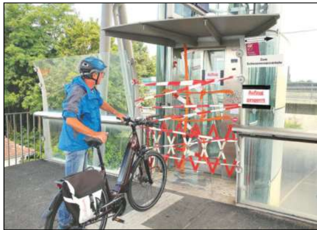
Kein Durchgang: Am Bahnhof Wiesloch-Walldorf ist einer der Fahrstühle defekt. Foto: Pfeifer
